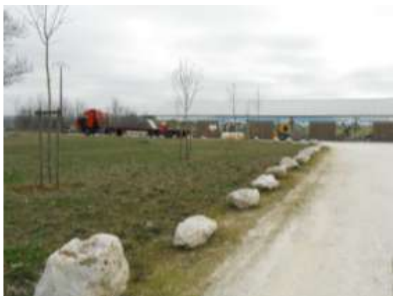
ZA d'éco-construction – vue de devant
